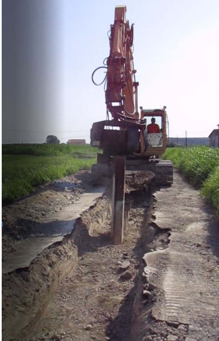
Particolare infissione palancole nella mezzeria della strada
