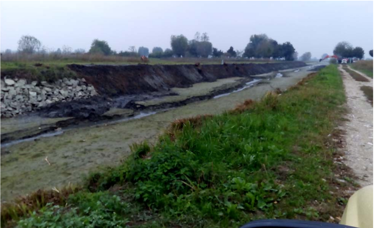
Ripresa frana nel canale Diversivo Casalasco in prossimità del sostegno Quattro Luci
