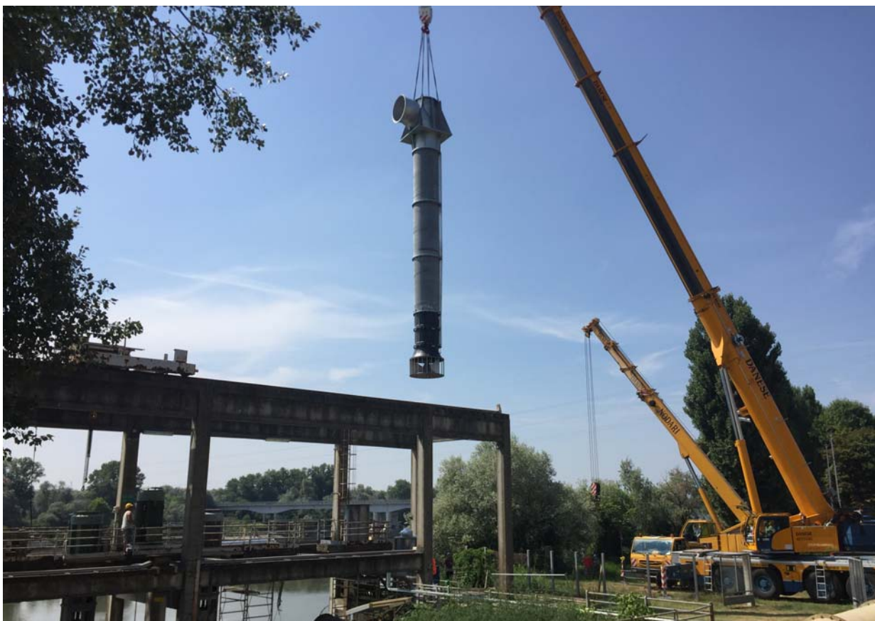
Posa della nuova pompa P4
