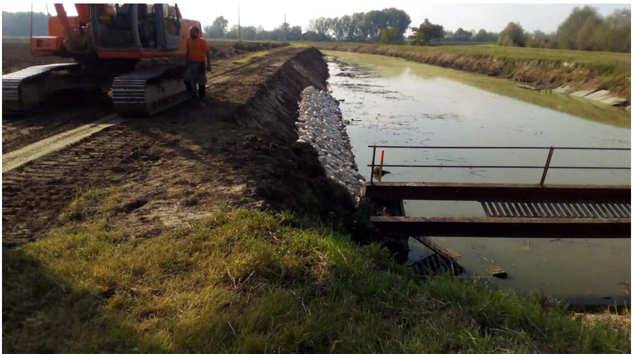
Ripresa frana nel canale Cavamento in prossimità dell'impianto Roncole di Gazzuolo
