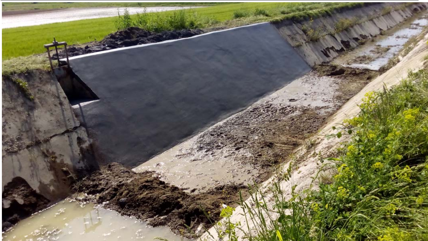
Ripristino rilevato arginale e nuovo rivestimento spondale in calcestruzzo armato
